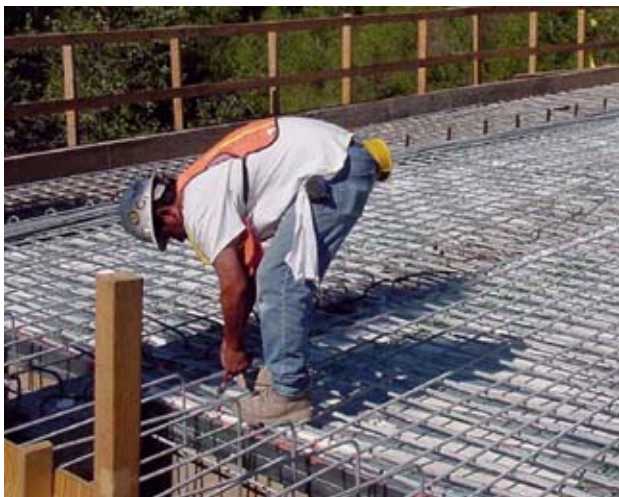
Obr. 10-15 – Žárově zinkovaná armatura v mostní konstrukci.
