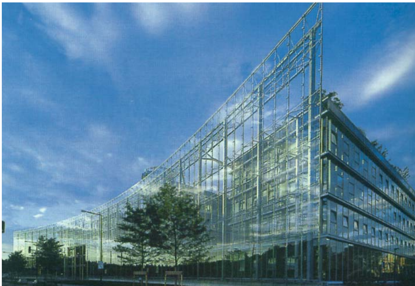
Skleněná stěna s žárově zinkovanou ocelovou kostrou.
